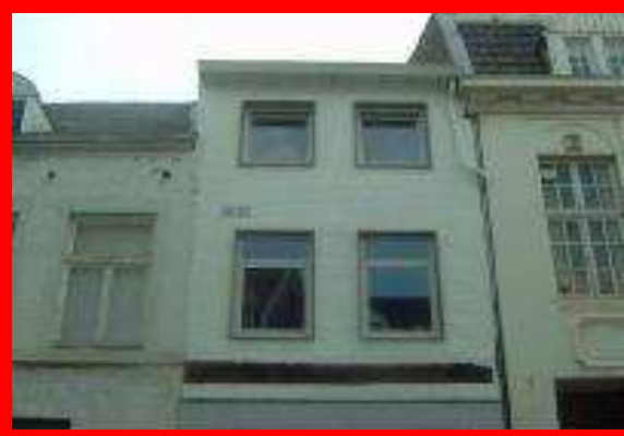
Verwijderen verf van gevels/ beton
